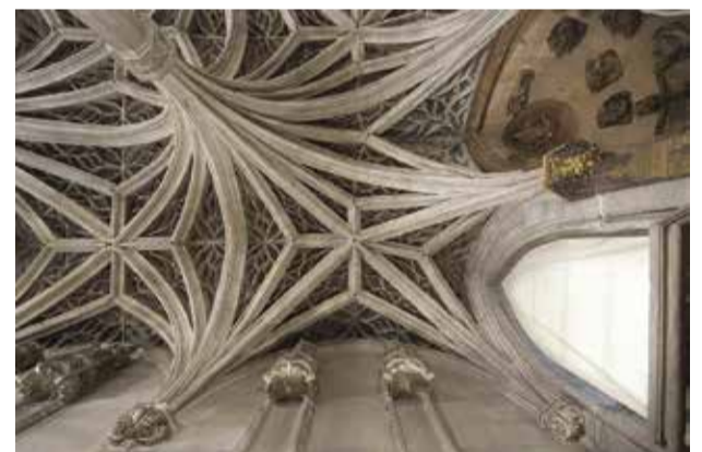
2 Détails de la voûte, mouchettes et soufflets
