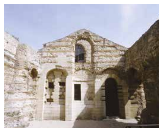
2 Salle chauffée - Caldarium vue vers l'est depuis le bd Saint-Michel
