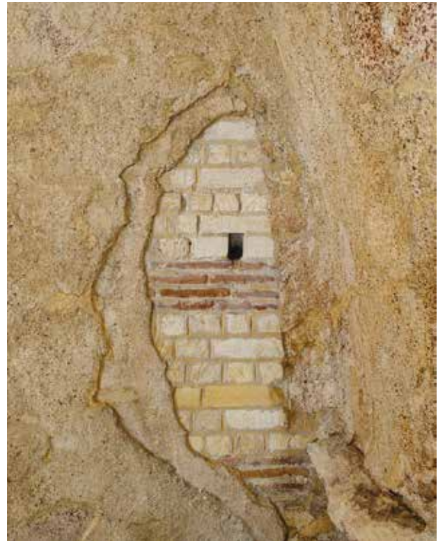
5 Superposition des couches d'enduits
